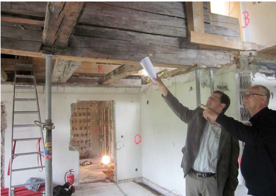
Klaus Ritter (li) und Ing. Karl Hörl (re) beim Lokalausganschein der Renovierungsarbeiten des Gemeindehauses.
